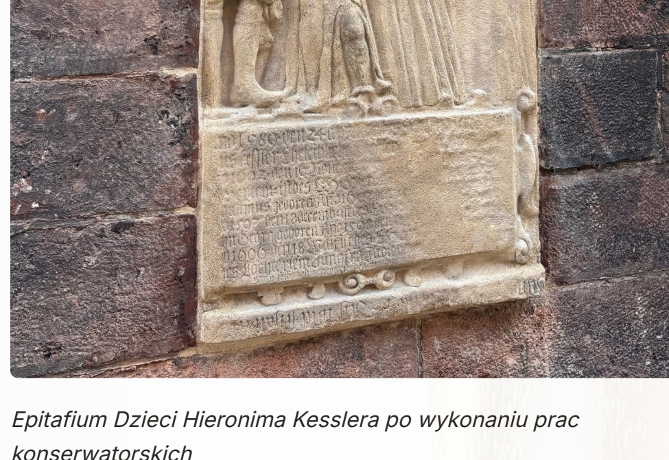
Epitafium Dzieci Hieronima Kesslera po wykonaniu prac konserwatorskich
